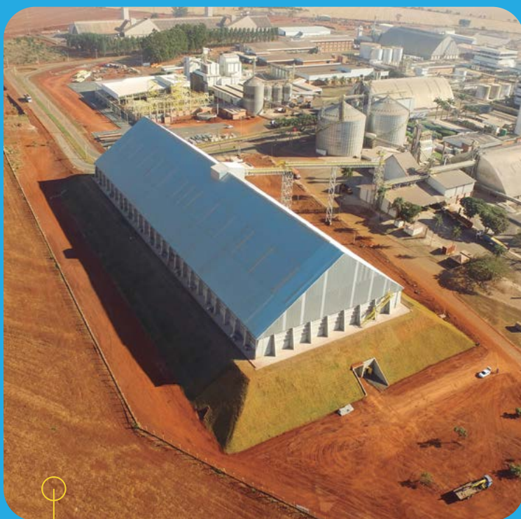
ARMAZÉM PARA MILHO (RIO VERDE) - Armazém Graneleiro com capacidade para 120.000 toneladas (2.000.000 sacas) para ser usado na armazenagem de milho no Parque Industrial e para dar suporte à nova fábrica de rações.
